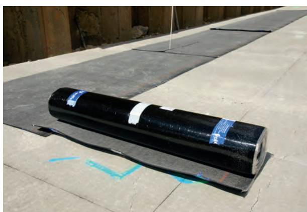
На подготовленное основание фундамента укладывается Wolfseal FBV для заливки бетона.
