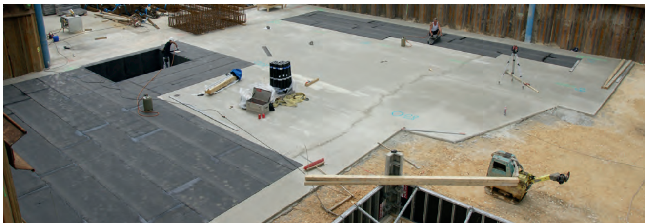
Укладка гидроизоляционного полотна Wolfseal FBV под бетонную плиту.
