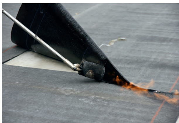
Спайка стыков осуществляется при помощи горячего воздуха или пламени газовой горелки.
