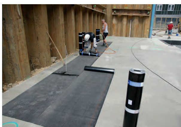
Раскладка гидроизоляционного полотна внахлест по красной маркировочной линии для дальнейшей спайки.
