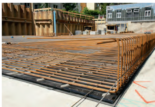
Арматурный каркас укладывается на гидроизоляционное покрытие.
